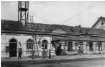
Stationsgebouw Lichtervelde (HKkvd2008_002)
