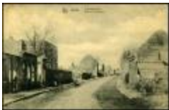
Verwoestingen in de Diksmuidestraat Staden (1418JD_072)
