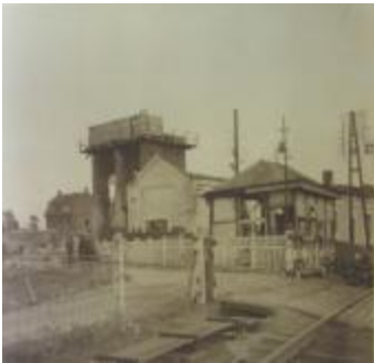
Overweg Izegemstraat, Ingelmunster, ca 1944 (BIN20121023_004)
